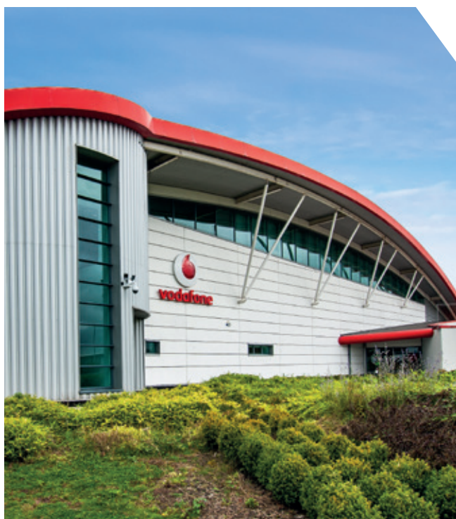
\\ Vodafone - Stoke-on-Trent - UK - Acquis le 01/07/2019
